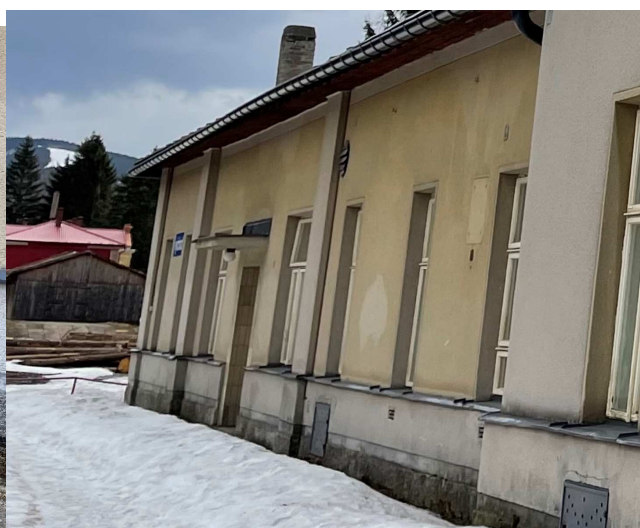
Obr.12 - Soklová část fasády s viditelnými větracími průduchy (štěrbínami) u podsklepené části budovy
