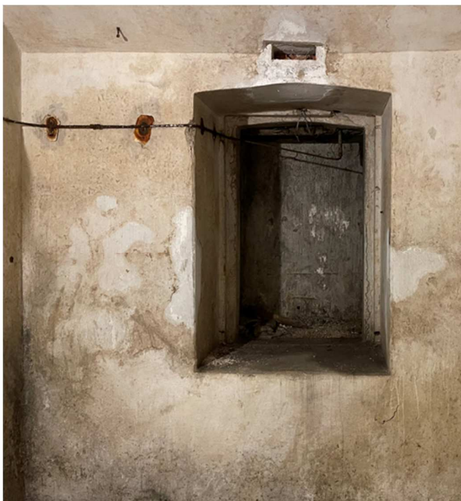
Obr. 5 – původní a nyní nefunkční odvětrání 1.PP
