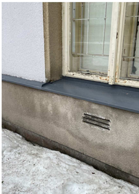
Obr. 13 - Detail větracích štěrbin – nedostatečná velikost pro funkční odvětrání suterénních prostor
