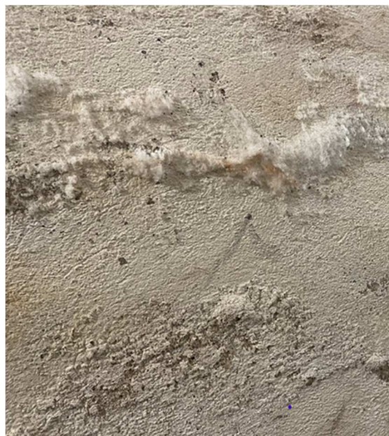
Obr. 6 – Solné výkvěty na obvodových konstrukcích v 1.PP
