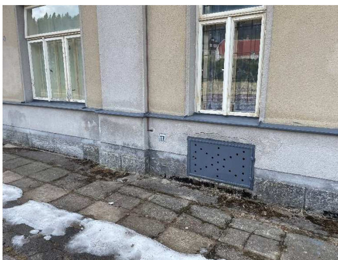
Obr.11 Současný stav – stav soklové části fasády, současné odvětrání suterénních prostor
